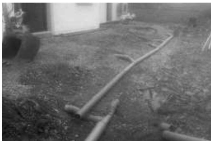
Raccordement des eaux usées d'une maison individuelle avec tuyaux renforcés type CR8 diamètre 125mm à joints ainsi que toutes les différentes pièces nécessaires au raccordement.
