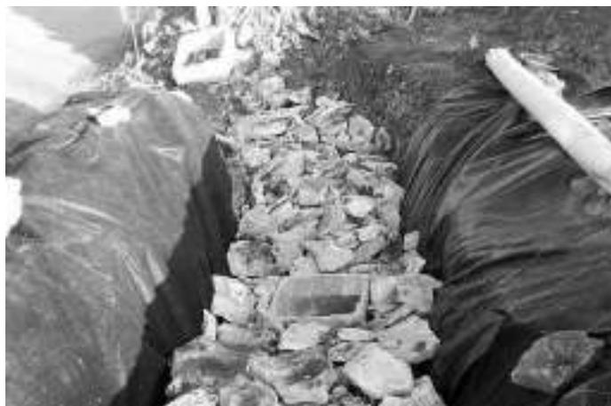
Puits perdu pour eaux pluviales avec regard de visite et remblaiement en matériaux drainants, le tout enveloppé d'un géotextile.
